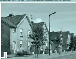
THIONVILLE, ROUTE DE MANOM Cité ouvrière dite « Cité des laminiers » construite en 1928 (moellon de calcaire, enduit ; mur de clôture : brique stitico-calcaire, enduit)
