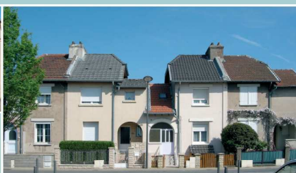
TERVILLE, PARC MON LOGIS. Cité construite en 1905. Deux modèles de maisons jumelles avec jardin, décor d'arcade en brique au-dessus des entrées et mur de refend pare-feu en saillie sur la façade et le toit. Réaménagée en 1981
